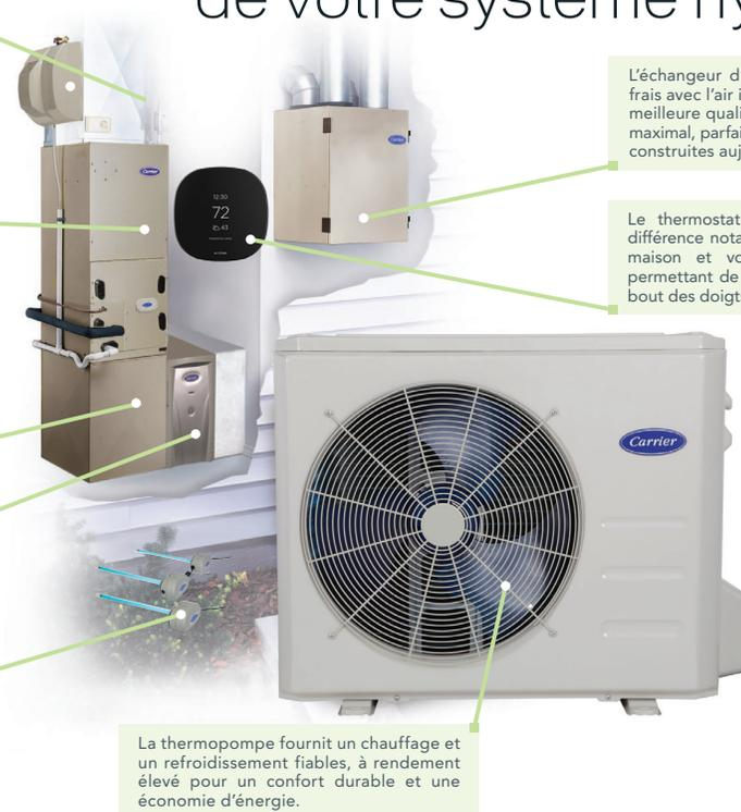
L'échangeur d'air combine l'air extérieur frais avec l'air intérieur climatisé pour une meilleure qualité de l'air et un rendement maximal, parfait pour les maisons étanches construites aujourd'hui.
